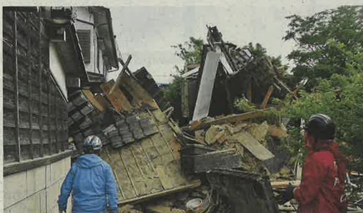
1月の地震で傾き、3日朝の震度5強の揺れで倒壊した家屋=3日午前、石川県珠洲市
